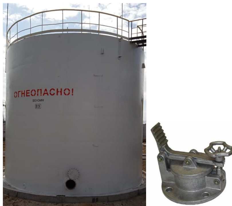
Рисунок 1 – Общий вид резервуара и замерного люка РВС-700 № 89
