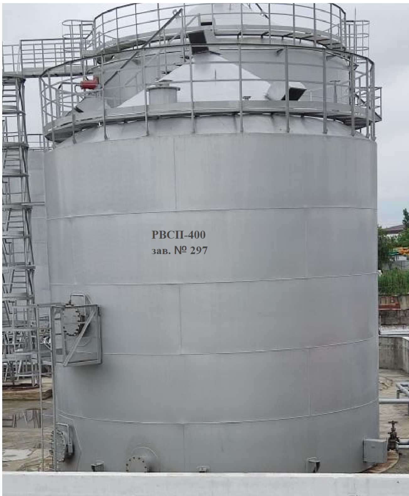
Рисунок 1 - Фотография общего вида резервуара РВСП-400 заводской номер 297
