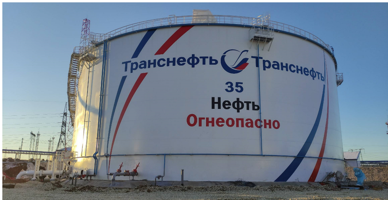
Рисунок 1 – Общий вид резервуара РВСП-30000 зав.№35
