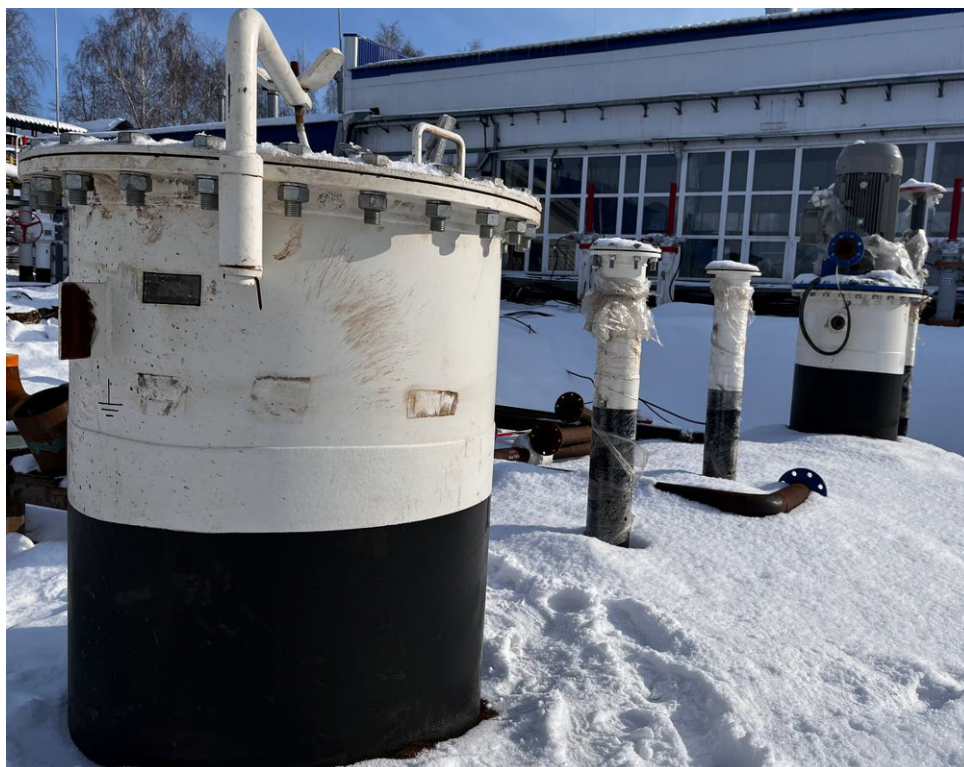
Рисунок 4 – Горловины и измерительный люк резервуара ЕП-40-2400-1500-А-СО-У1 зав.№ 6955
