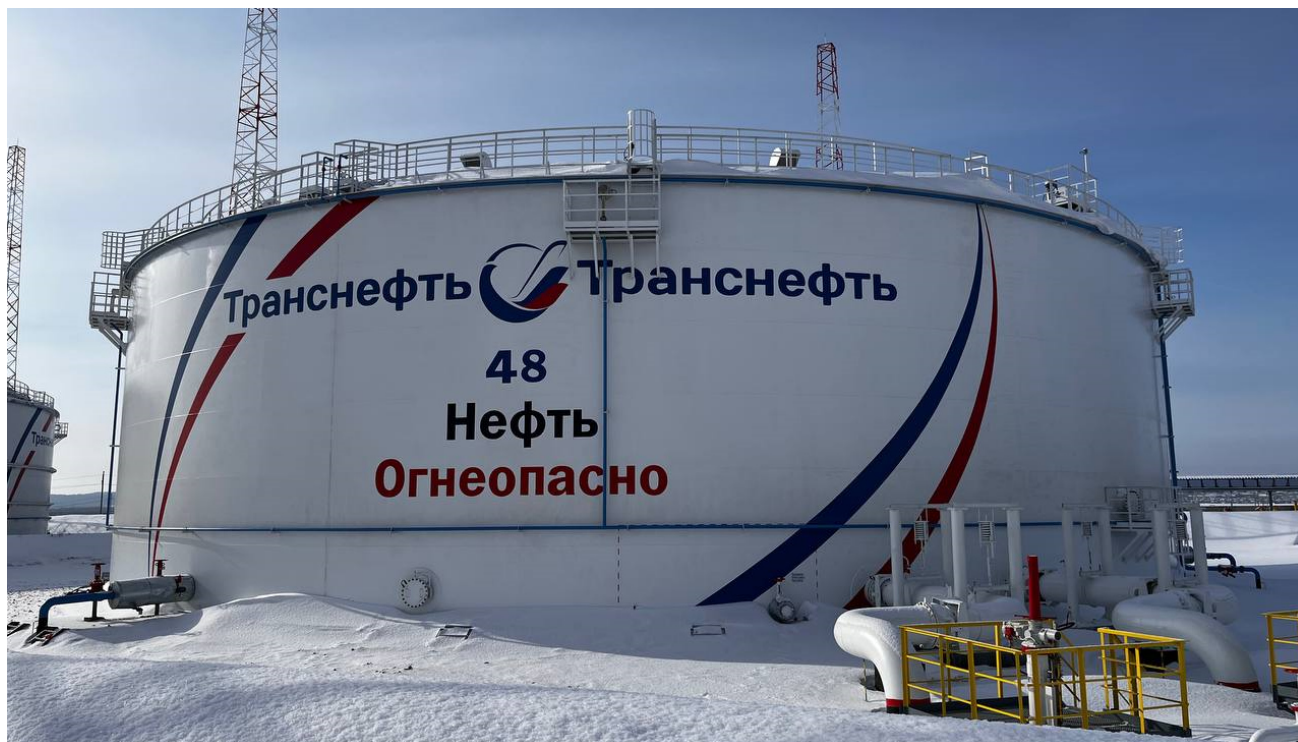
Рисунок 1 – Общий вид резервуара РВСП-20000 зав.№48
